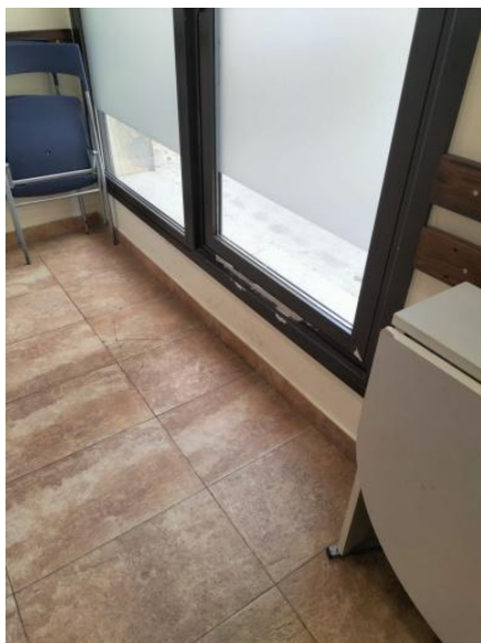
Segons CTE DB-SI i DB-SUA l'alçada màxima d'un graó ha de ser de 18.5 cm.
